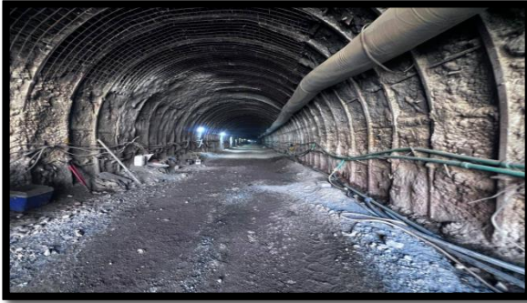
صورة رقم (٢٥) النفق الثاني للمشروع
