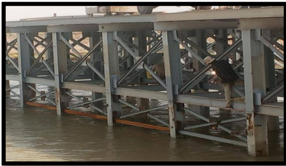
صورة رقم (٢١) الركائز الحديدية لجسر فضائي
