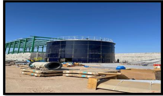
صورة رقم (٥) نصب خزانات الماء المعالج والهياكل الحديدية لابنية المحطة
