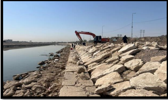
صورة رقم (١٩) التكسية الحجرية للمشروع
