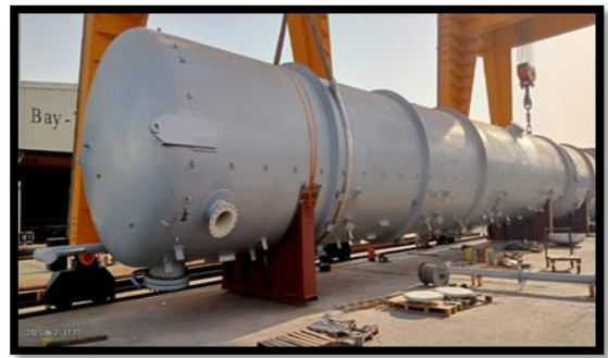
صورة رقم (٣) اعمال نصب خزان معالجة ازالة الاوكسجين من الماء المعالج
