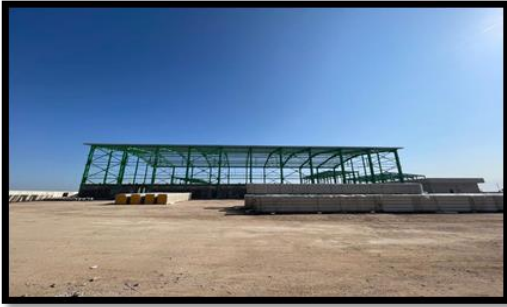
صورة رقم (٦) نصب الهياكل الحديدية لابنية المحطة
