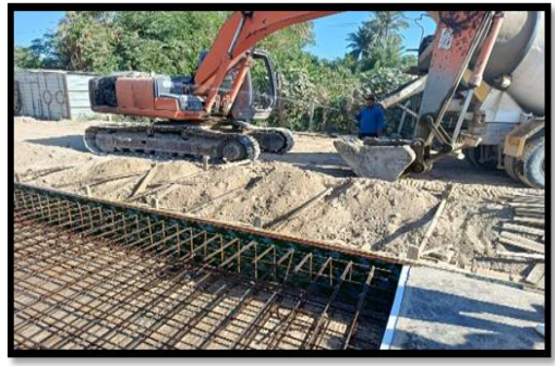
صورة رقم (١) اعمال تسليح الماشي المحاذية لضفاف شط الحلة
